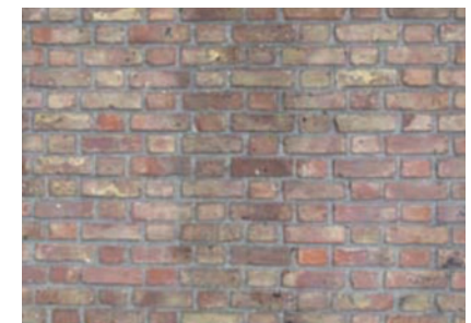
figuur 6. Vlaams verband in het Provinciaal Instituut voor Tuinbouwonderwijs in Mechelen (1927-1930).
