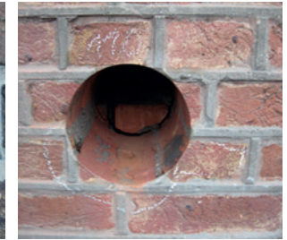
figuur 28. Gesneden voeg in de Provinciaal Technische Scholen in Boom (1926-1930).
