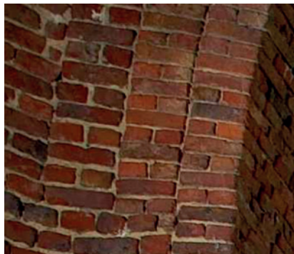
figuur 8. Detail van de Koninklijke ijskelders in Brussel (1875 en 1894)
