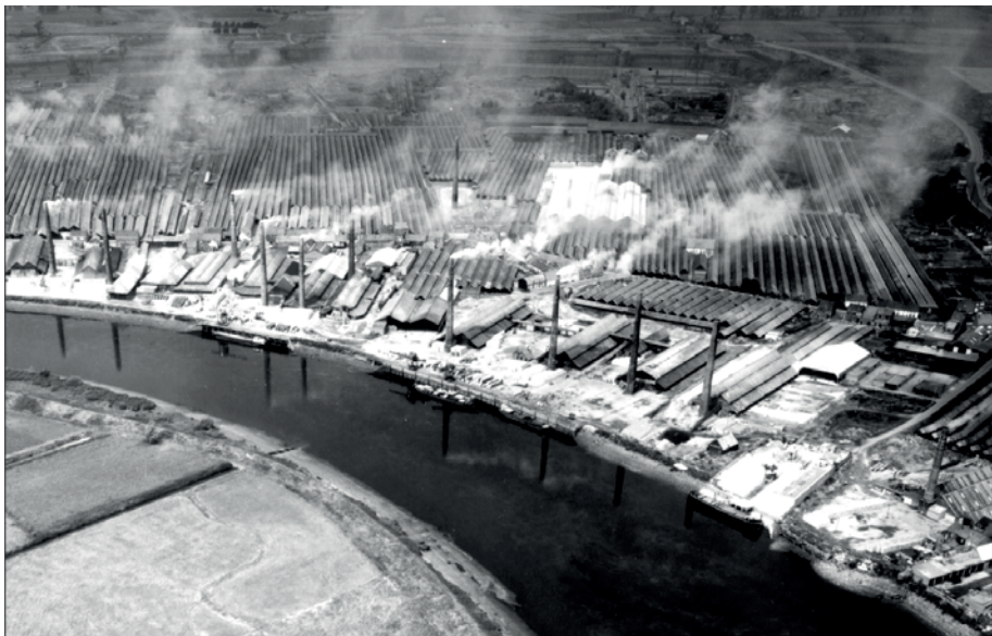
figuur 10. Luchtfoto van het gehucht Noeveren in Boom, genomen tussen 1962 en 1965. Elke schoorsteen is verbonden met een rechthoekige Hoffmann-oven met een capaciteit van 1,2 miljoen stenen. Per oven was 8 à 9 km aan droogloodsen nodig om het continue bakproces gaande te houden. Daarnaast zijn ook enkele klampovens op de foto te zien.
