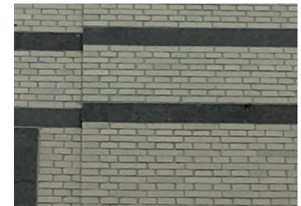
figuur 5. Staand verband in de woning J. Van Schoote in Gent (1905).
