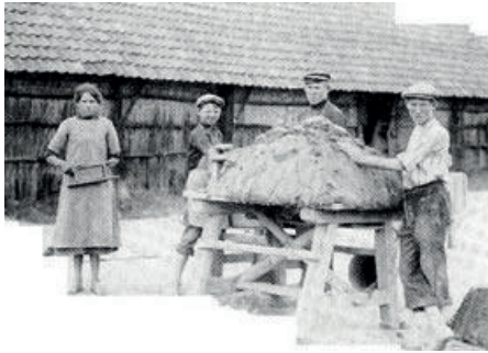
figuur 6. Foto uit 1900 van de steenmakerstafel met twee afdragers, de steenmaker en een opzetter.
