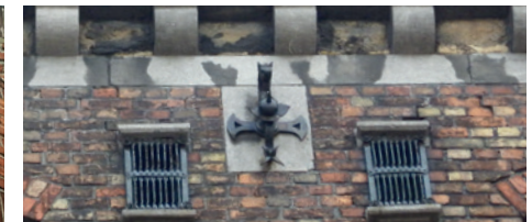
figuur 41. Zichtbare ankersleutel in de Leopoldskazerne in Gent (1890-1905).
