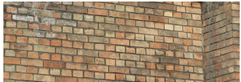
figuur 1. Kruisverband in de Sluismeesterwoning in Antwerpen (1908) (boven) en de Leopoldskazerne in Gent (1890-1905) (onder).
