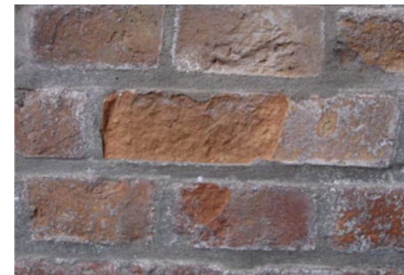
figuur 10. Detail van de gevel in bastaardmortel van de toren van de Christus-Koningkerk in Brugge (1931).
