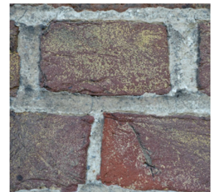
figuur 7. Detail van de gevel in hydraulische kalkmortel van de Sluismeesterwoning in Antwerpen (1908).
