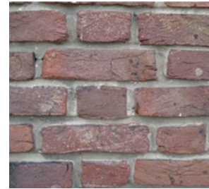
figuur 26. Verdiepte voeg in het Provinciaal Instituut voor Tuinbouwonderwijs in Mechelen (1927-1930).
