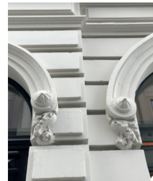
figuur 44. Basement bekleed met een bepleistering van bastaardmortel in de woning D. De Jaeger in Gent (1888).
