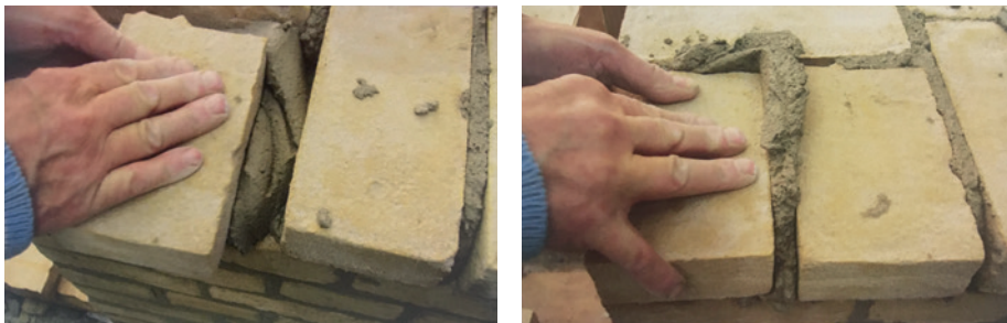
figuur 19. Vol en zat metselen
