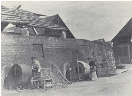
figuur 8. Foto van een klampoven met rieten dak. Twee arbeiders wakkeren het vuur aan met blaasmolens.
