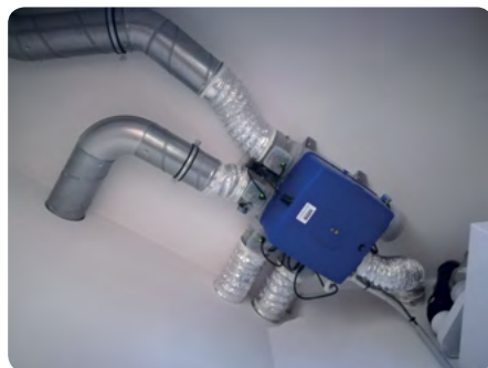
Ventilator voor mechanische afvoer in systeem C
