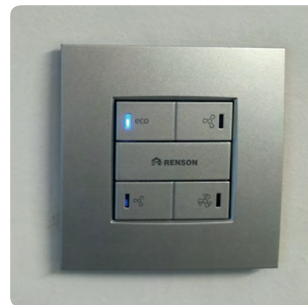
Manuele regeling voor centraal systeem C
