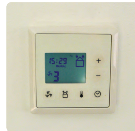
Programmeerbare bediening met klok © WTCB
