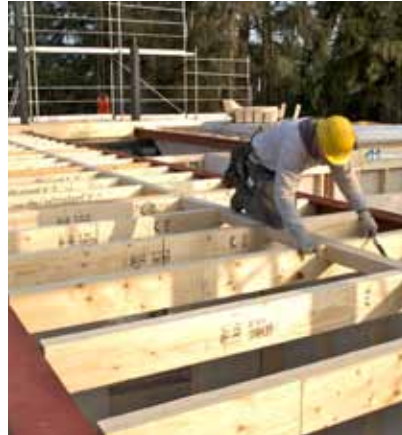
STEICO LVL R: een bijzonder draagkrachtig element voor de opbouw van vloeren.
