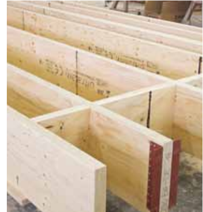
Prefabricage van vloerelementen.
