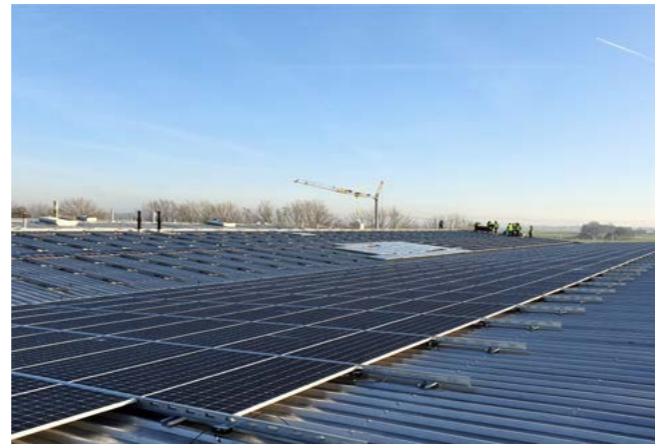
ZONNEPANELEN DIRECT OP DAKGORDINGEN BEVESTIGD
